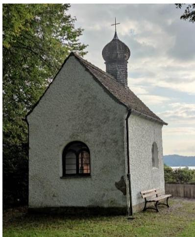
Die letzte Sanierung der Straßenkapelle liegt bereits viele Jahre zurück. Inzwischen sind einige Mängel an der Fassade und am Dach sichtbar. Die Westseite weist Putzabplatzungen und Verfärbungen auf. Zudem sind auf der Nordseite tiefe Risse zu erkennen, die verpresst werden müssen. Hierfür wird der Putz freigestemmt und das Mauerwerk mit Edelstahleisen so verdübelt, dass sich die Risse nicht weiter fortsetzen können. Anschließend müssen die
