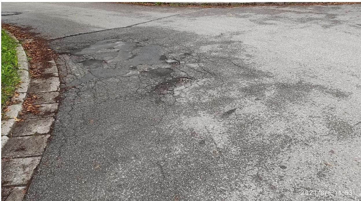
Zudem werden im Zuge der Belagssanierung die Betonbordsteine in den geschädigten Bereichen durch dauerhaftere Granitbordsteine ersetzt. Bei der Erstellung der Straße wurden größtenteils Betonbordsteine verwendet, die sich als nicht beständig erwiesen haben. Die Bordsteine sind auf lange Strecken durch Frost und mechanische Einwirkungen zerstört.
