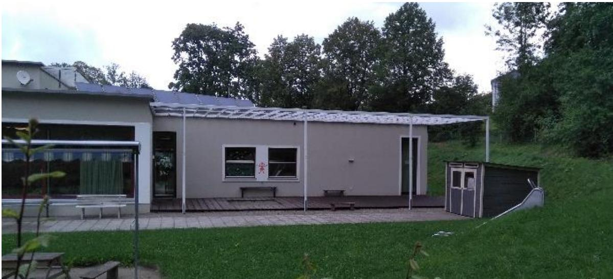
Ursprünglich sollte die Beschattung der Terrasse durch ein Sonnensegel erfolgen. Dies war jedoch für die vorhandene Stahlkonstruktion mit einer Höhe von über drei Meter und einer Fläche von 65m<sup>2</sup> ungeeignet. Die Windbeständigkeit war ungenügend und auch die Handhabung war ungünstig. Das Sonnensegel sollte daher in dieser Form nicht erneuert werden.
