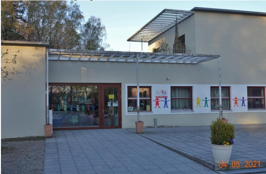
Um hier Abhilfe zu schaffen, plant die Gemeinde Feldafing die Errichtung einer Glasüberdachung auf der vorhandenen Pergola-Konstruktion im Eingangsbereich. Die vorhandene Pergola soll dabei nicht komplett mit einem Glasdach versehen werden. Der überdachte Bereich wird nur über dem Türelement und dem anschließenden Fenster erfolgen.
